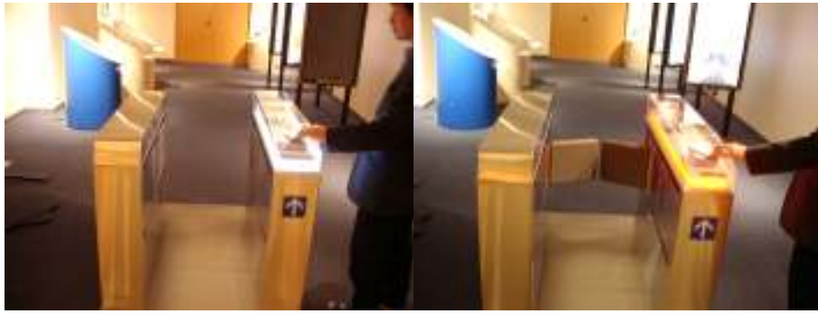
図 5.1-2：ゲートが開放した例と（左）、トークンがなくて、エラーとなった例（右）
